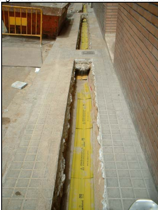
Fotografia 2: Tram general de la Rasa 100, amb la línia d'alta tensió en tot el seu recorregut.
